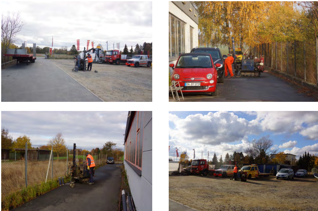
Abbildung 2: Projektgrundstück zum Zeitpunkt der Erkundungsarbeiten im November 2018
