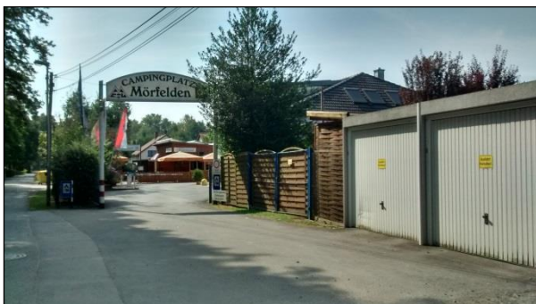
Abb. 2: Blick auf den Eingangsbereich zum bestehenden Campingplatz.
