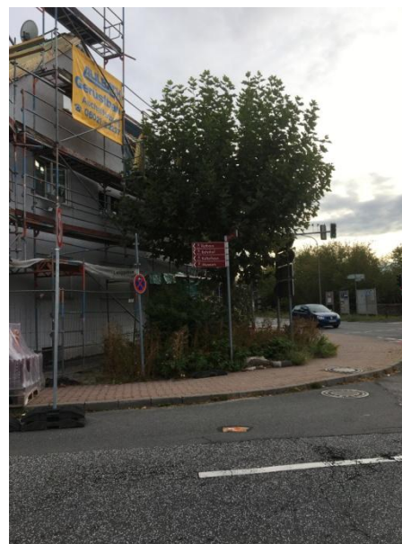
Bild links: Beschilderung am Bahnhof Mörfelden Richtung Stadtmitte / Langener Straße: Frequenzabbruch durch leerstehende Ladenlokale / Bild rechts: Beschilderung Richtung Rathaus Ecke Langgasse / Gerauer Straße
