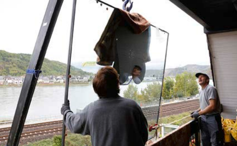
Einbau von schalldämmenden Fensterscheiben in einem Fachwerkhaus am Mittelrhein
