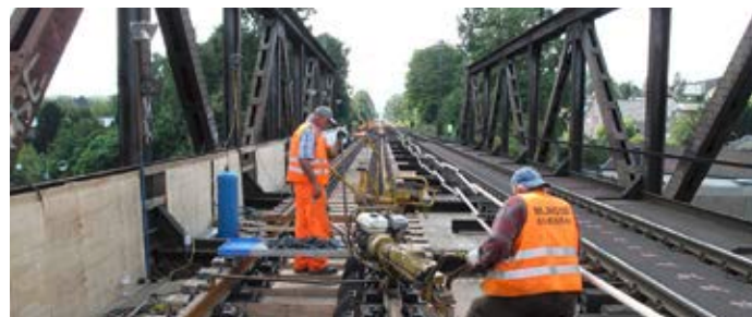
Entdröhnung einer Brücke in Herzogenrath
