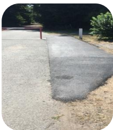
Nahe des Naturfreundehauses (Am Zeltplatz) wurde neben der (leider notwendigen Schranke) ein Bereich der Grünfläche asphaltiert. Hierdurch kann die Schranke wenigstens bequem umfahren werden.
