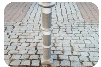
Damit es im Dunklen und Dämmerung nicht zu ungewollten Kollisionen kommt, werden alle Poller im Stadtgebiet mit Reflektoren ausgerüstet. Zusätzlich werden auf Radwegen rot-weiß beschichtete Poller verwendet.
