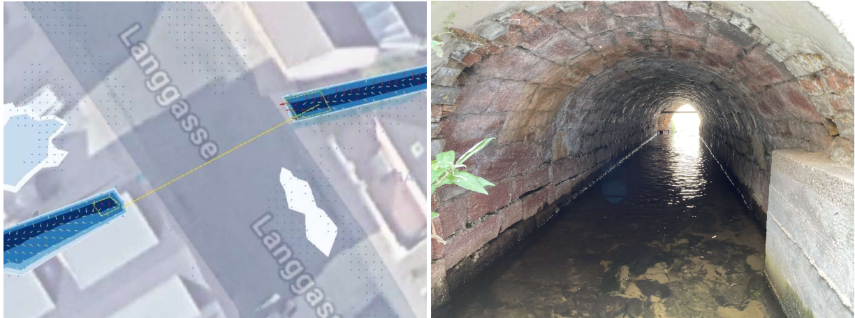
Abbildung 13: Abbildung des Gerätsbach-Durchlasses in der Langgasse (links: Nachbildung im Modell, rechts: Aufnahme des Durchlasses vor Ort)
