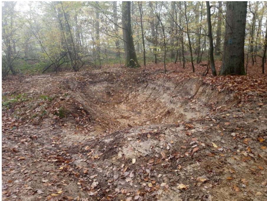
Abbildung 20: Kleinstrückhalt an einem Forstweg (Foto: BGS Wasser)
