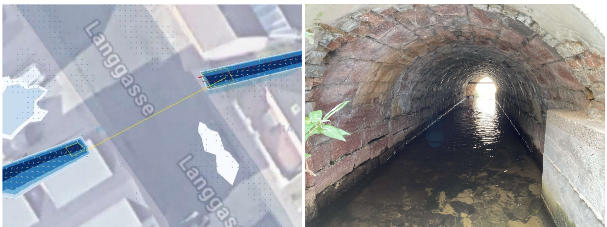
Abbildung 12: Abbildung des Geräthsbach-Durchlasses in der Langgasse (links: Nachbildung im Modell, rechts: Aufnahme des Durchlasses vor Ort)
