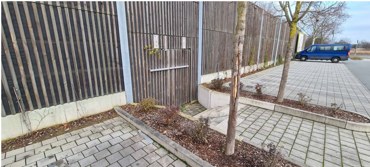
Abb. 12: Treppenanlage und Tür in bestehender Schallschutzwand
