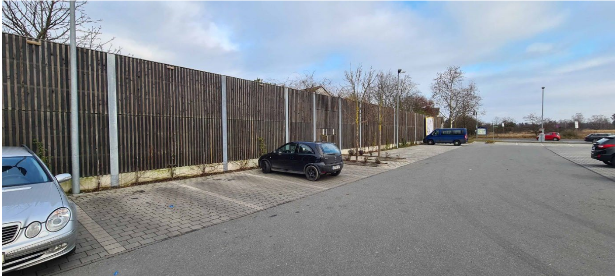
Abb. 8: Bestehende Schallschutzwand im Norden des Plangebietes
