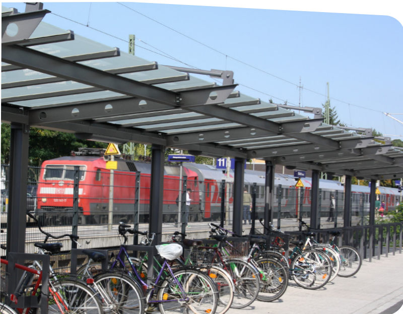
Abb. 47: Bike + Ride Bahnhof Walldorf vor Bau der Lärmschutzwände
