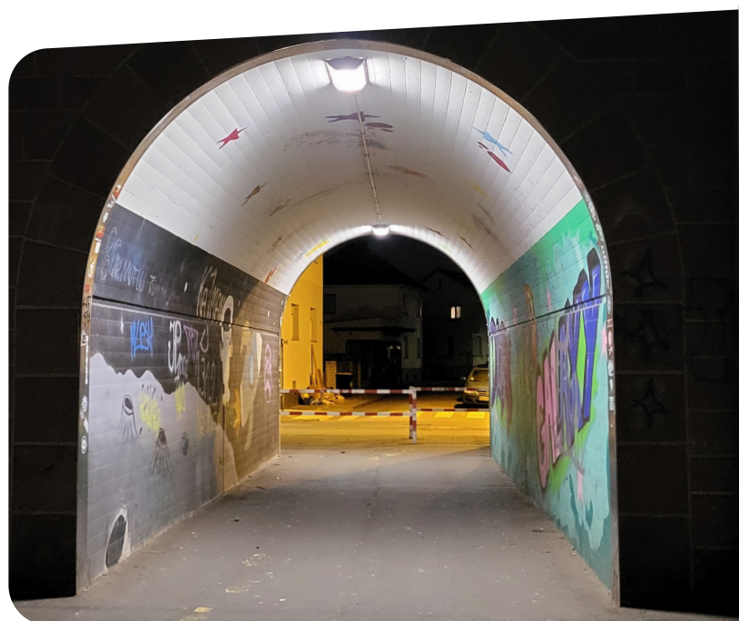
Abb. 43: Beleuchtete Unterführung für Fußgänger und Radfahrer in Mörfelden
