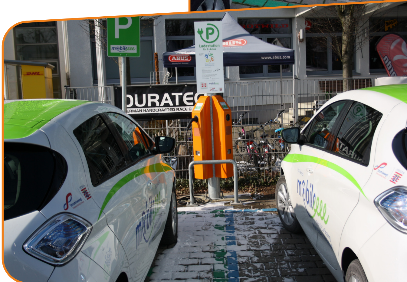
Abb. 71+72: E-Ladestationen und E-Carsharing am Walldorfer Bahnhof (unten) sowie am Mörfelder Bahnhof (oben)
